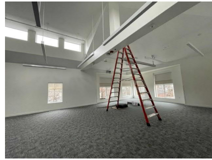
4. Second floor AV work in progress.
